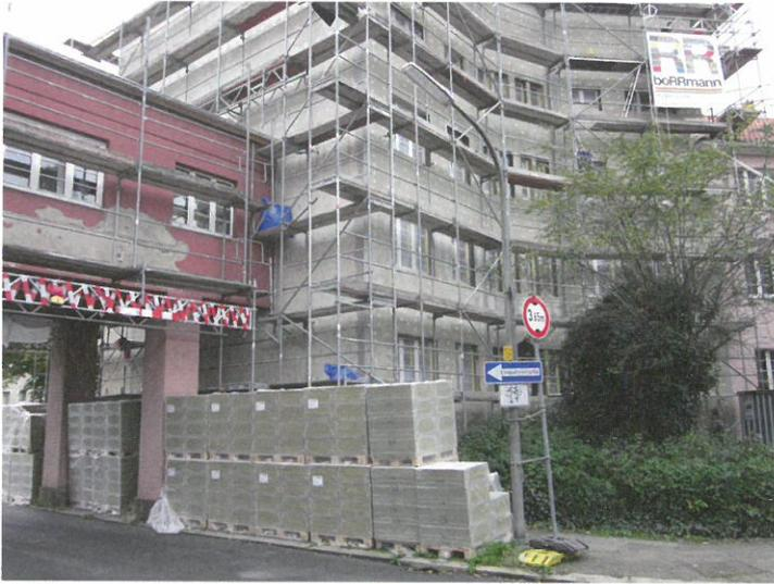
3 Der Abstand vom Gerüst zur Fassade wurde durch Konsolen auf die Putztechnik abgestimmt.
