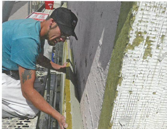
4 Die historische Fassade wurde mit einem mineralischen Wärmedämmsystem gedämmt.
